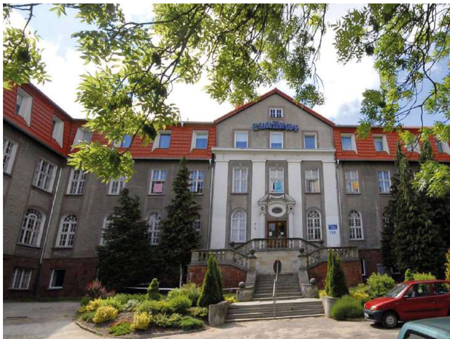
Sanatorium Uzdrowskie „Chrobry” jest otoczone parkiem i znajduje się na niewielkim wzgórzu w zacisznej części Kamienia Pomorskiego, niedaleko mariny.
